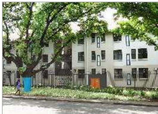
Campus Key Potchefstroom (Berts Bricks)
